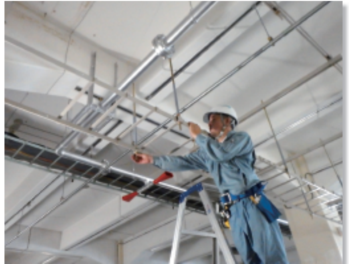
■ ケーブルラック取付工事
