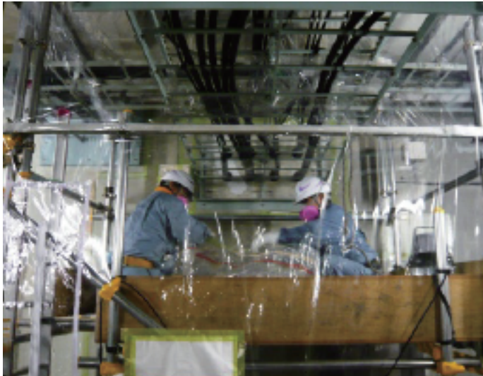
■ アスベスト除去工事（通信用ケーブルホール）
