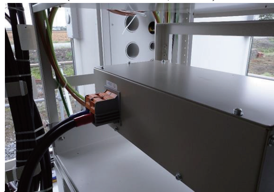
(カバー設置後)
