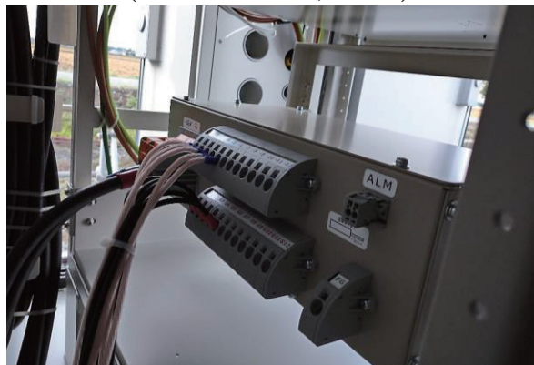
(カバー設置後)
