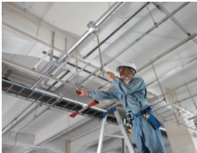
■ ケーブルラック取付工事
